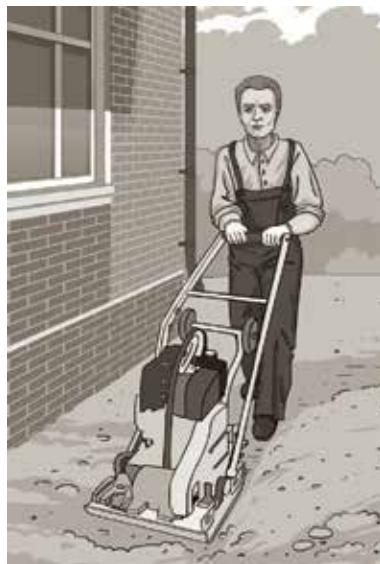
Качественное выполнение работ по подготовке основания на больших площадях может быть обеспечено при использовании автотракторной техники: бульдозер, грейдер, каток и пр.. Участки площадью до 100-150 кв.м, а также участки сложной формы, удобней подготавливать с помощью специального электро- и бензоинструмента (виброплита, виброборейка и пр.)
