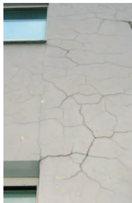
Рис. 16а. Трещины на штукатурке, затворенной избытком воды
