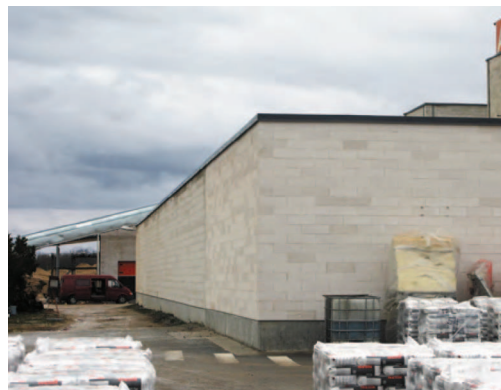
Рис. 4. Завод по производству автоклавного газобетона со стенами из неотделанной кладки, 2002 г.п., Эстония, волость Сымеру
